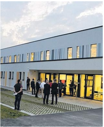
Die Außenanlagen an der neuen Turnhalle und der Schule müssen erneuert werden. Foto: Simone Zeh
