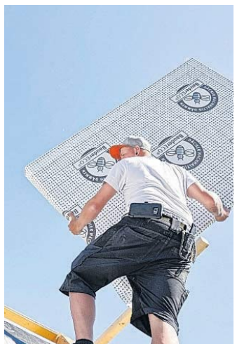
Energiesparen fängt unterm Dach an: Mit einer Aufsparrendämmung sparen. Foto: djd/Paul Bauder/Michael Gallner
